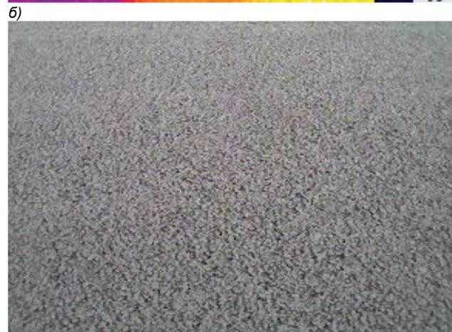
Рисунок 9. Последствия 15-ти минутной остановки асфальтоукладчика по техническим причинам
